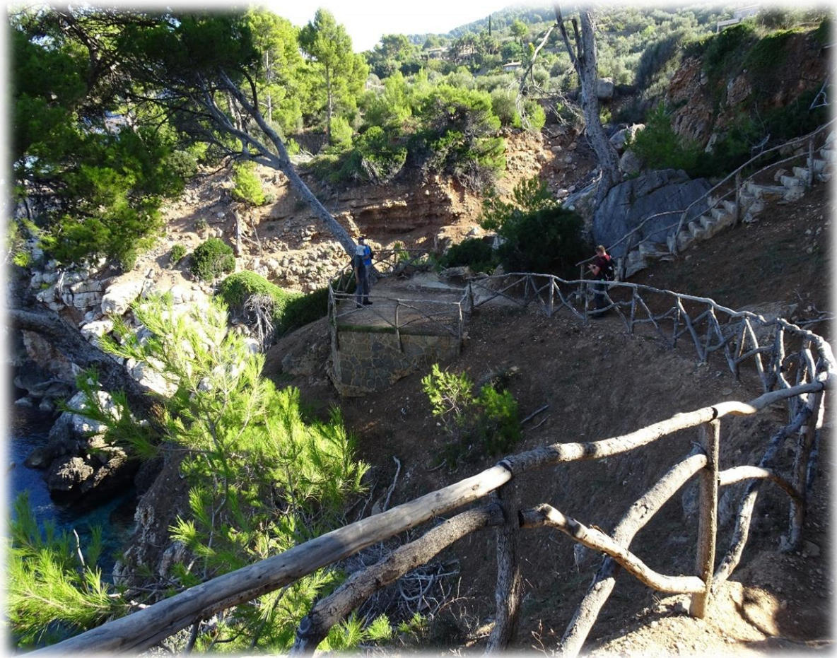
Op sommige plaatsen heeft men houten afspanningen gemaakt om ongevallen te vermijden.
